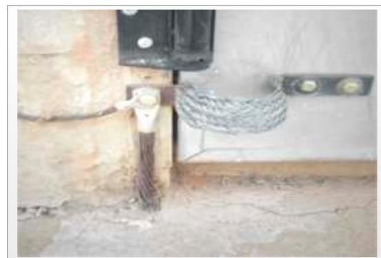
As Cordoalhas Flexíveis são utilizadas para Aterramento de portões metálicos, estruturas móveis ou em juntas de dilatação.
