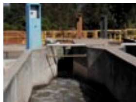
Levantamento de vazão da ETE
