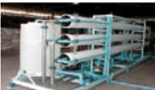
Sistema de Osmose Reversa
