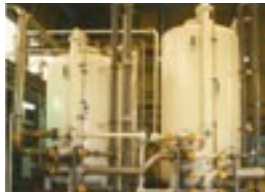
Sistema de Deionização
