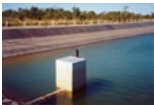
Medição de nível em lagoa
