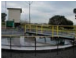
Tratamento de Efluentes
