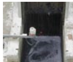
Medição de nível em esgoto
