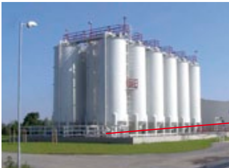
Monitoramento de nível múltiplo
